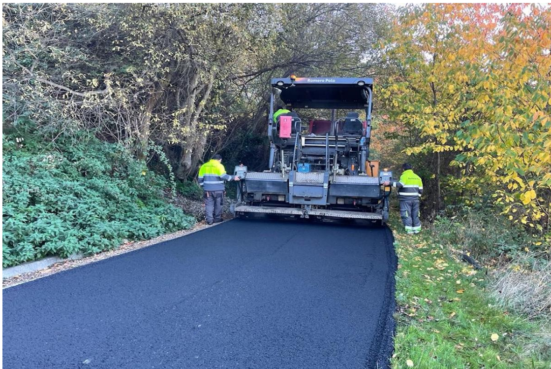
Uns operaris asfaltant una carretera pallaresa | CCPS
