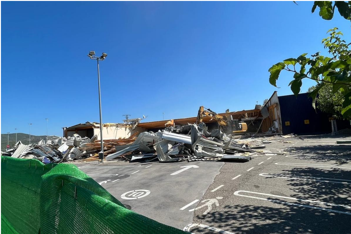
Una retroexcavadora desballestant l'edifici de l'antic supermercat | TGE
