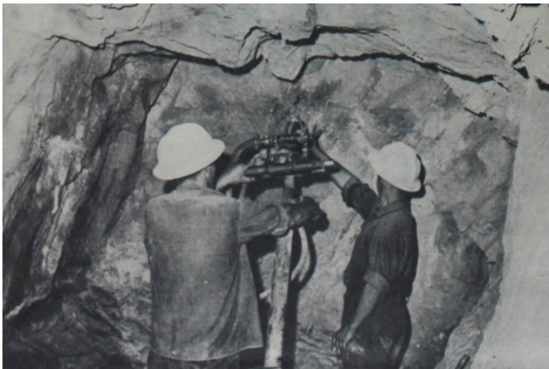
Dos miners extraient material d'una galeria amb un martell neumàtic Foto: Arxiu Comarcal del Pallars Jussà / fons Andreu Gelabert i Magret
