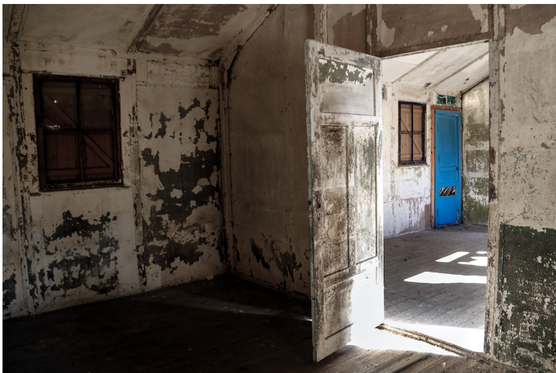
Interior d'una de les sales de cures de l'antic hospital | ACN
