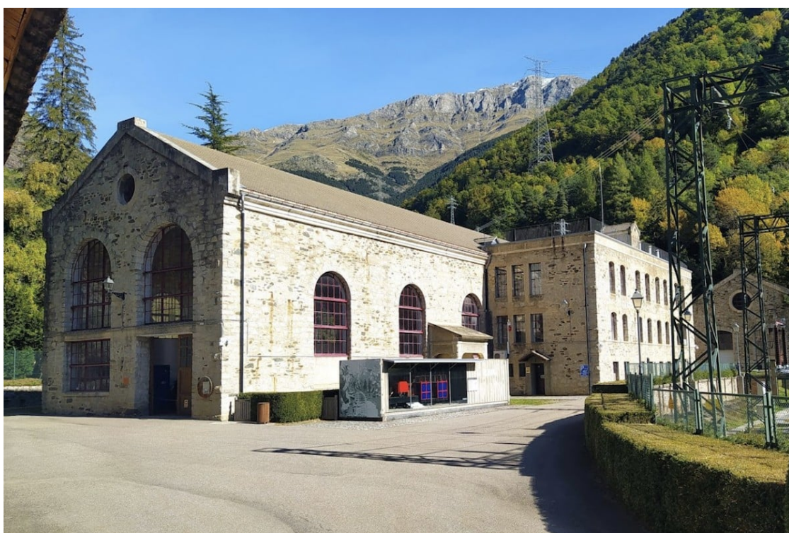
Imatge de la central hidroelèctrica de Capdella | Arxiu
