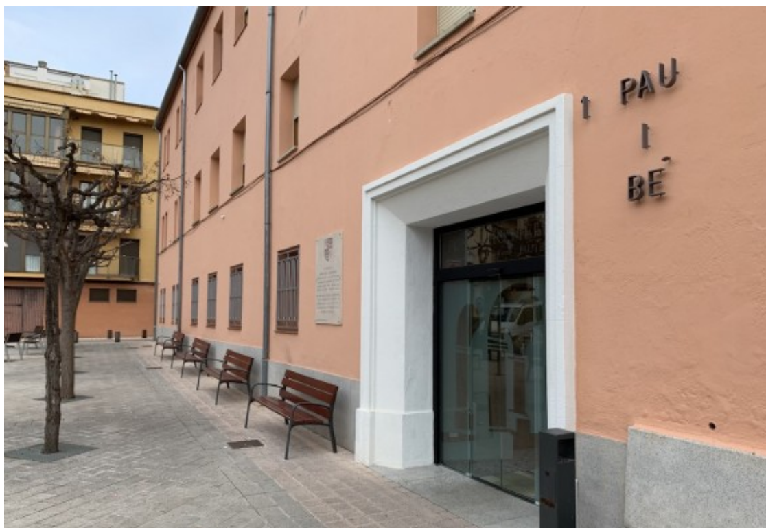
Entrada a la residència Fundació Fiella de Tremp. Foto: Jordi Ubach
