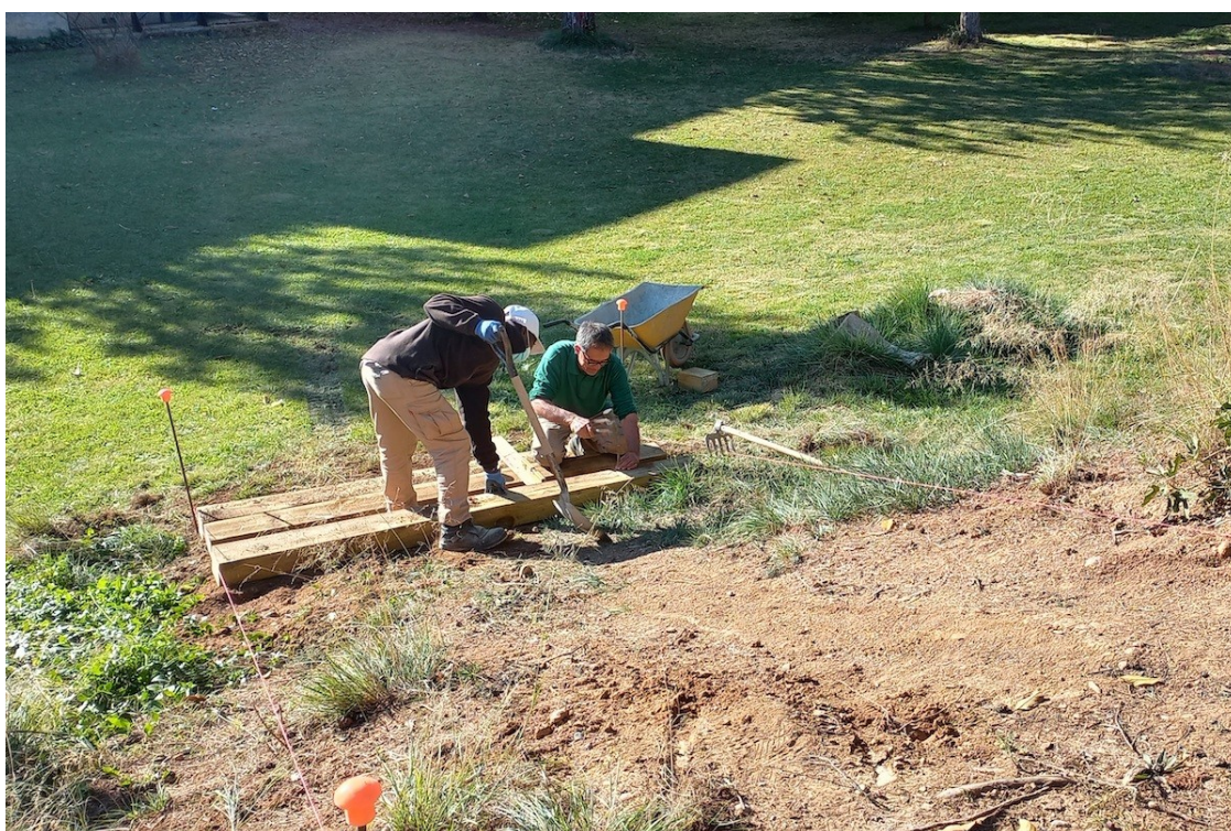
Dos operaris treballant a les obres del parc | CCPJ
