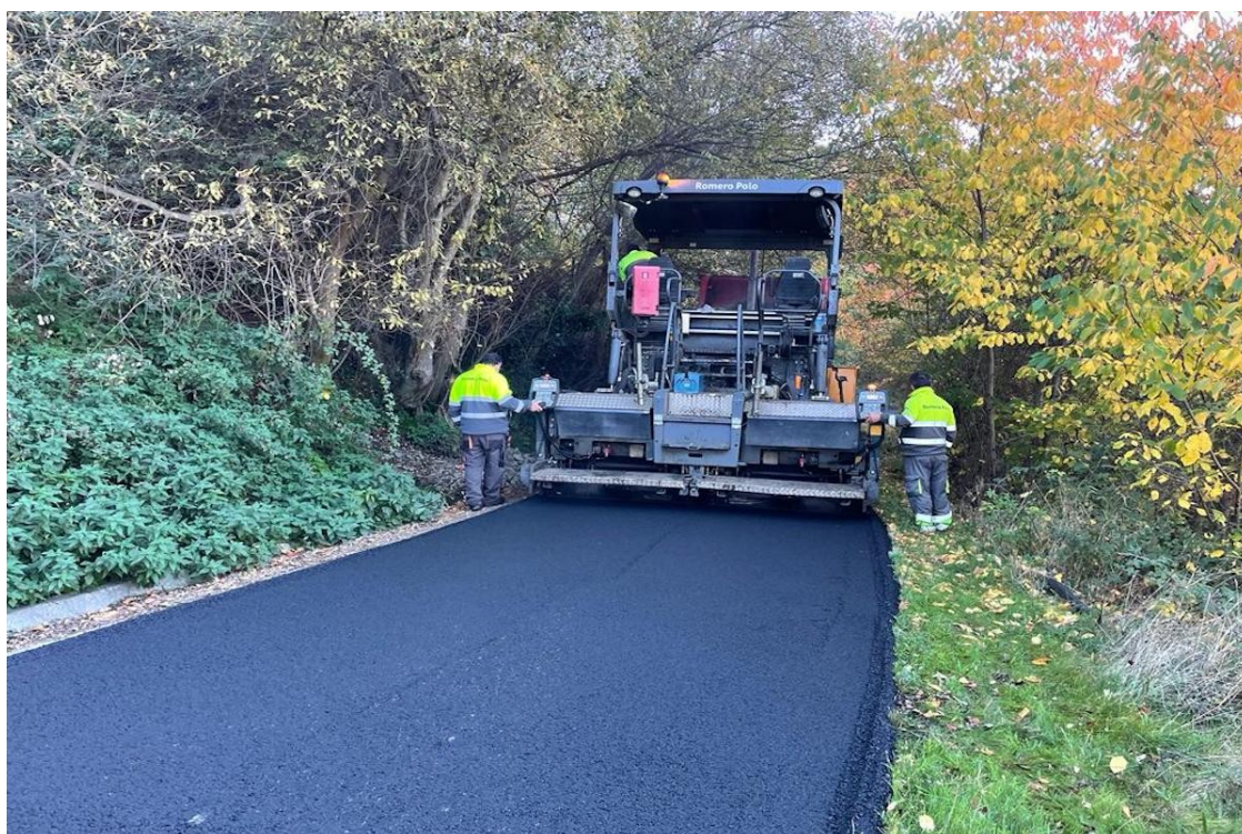
Uns operaris asfaltant una carretera pallaresa | CCPS
