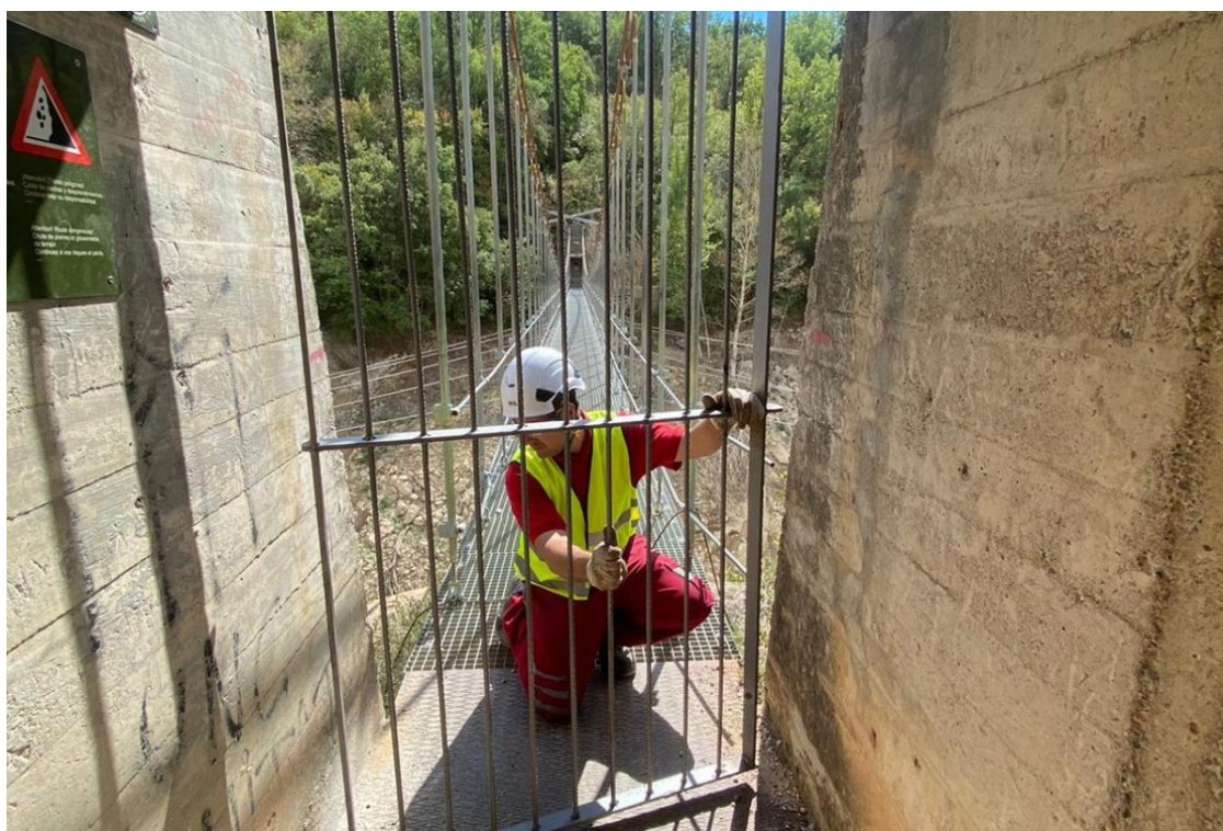
Un operari instal·lant una de les portes d'accés al congost | Jordi Navarra
