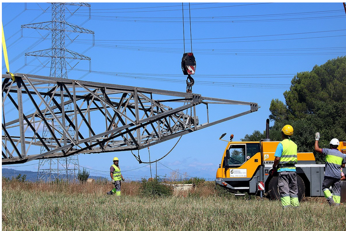
Treballs en una torre d'una línia de molt alta tensió, en imatge d'arxiu | ACN
