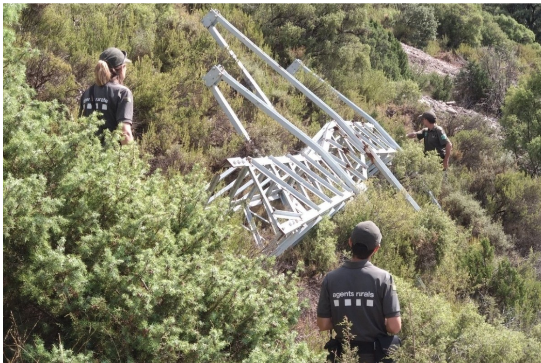
Imatge de la torre elèctrica abandonada enmig de la vegetació | Agents Rurals
