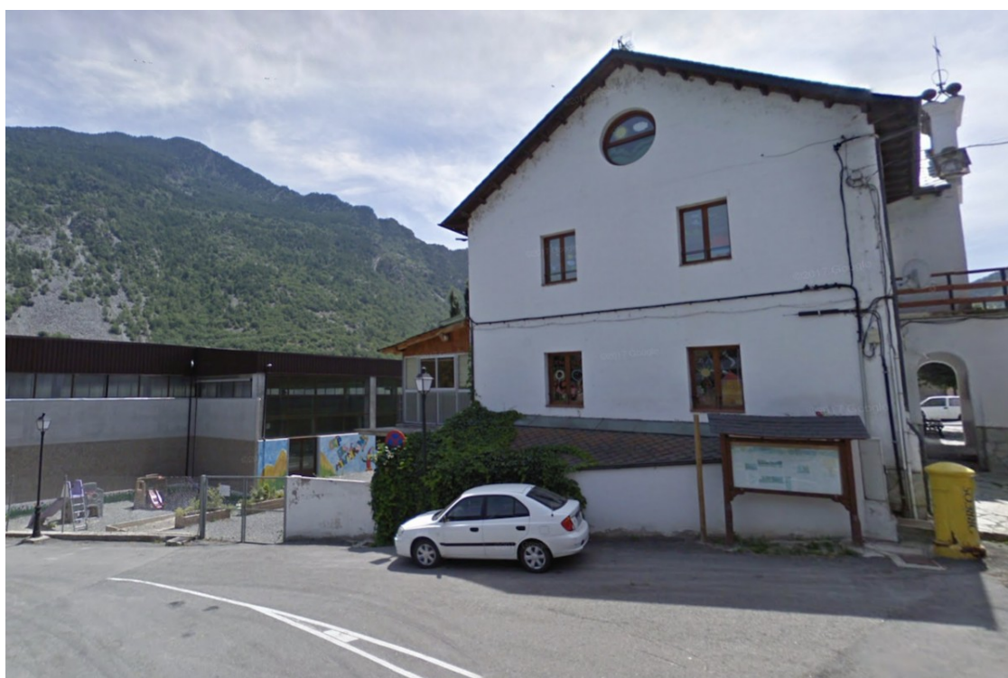
Imatge exterior de l'Escola Els Minairons de Ribera de Cardós | GSV
